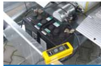
Elektrické ovládání hydrauliky
